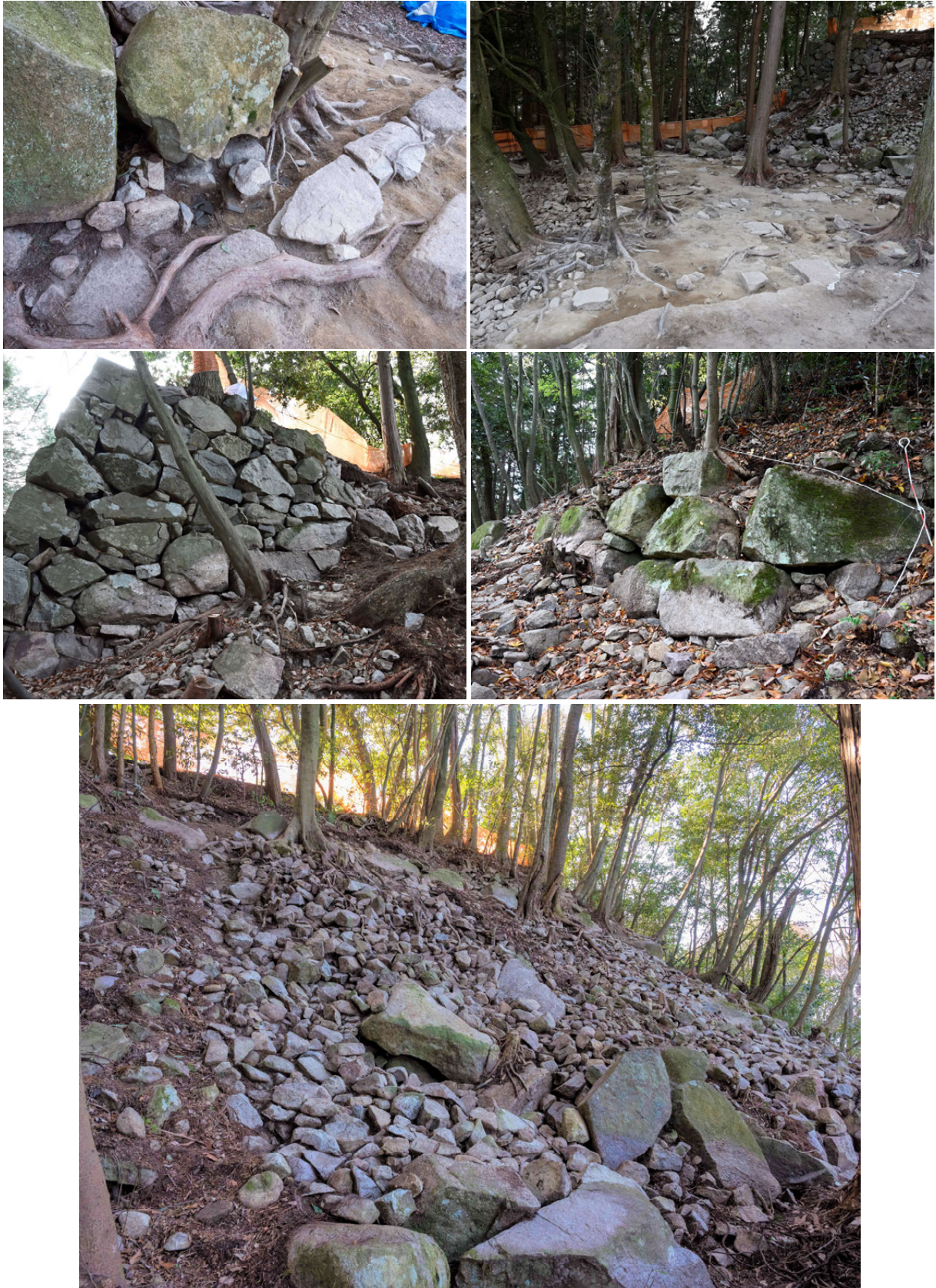
PL17 令和5～6年度発掘調査 本丸取付台・天主台東～北東面写真（上左：本丸取付台建物西側石列外側の状況（南東から）上右：R6調査区（Ⅰ区）全景（北東から）中左：天主台東面石垣南端（東から）中右：天主台北北東隅角部（北東から）下：天主台東面崩落状況（南東から））
