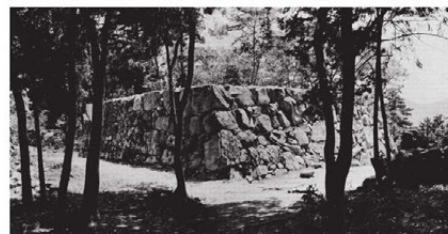
写真 34 ㉒本丸台地入口隅櫓石垣北西面 (修理後)
