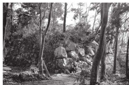
写真 33 ㉑本丸台地入口隅櫓石垣北西面 (修理前)
