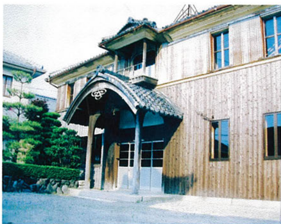
現存する明治十年建築の「至誠学校」
