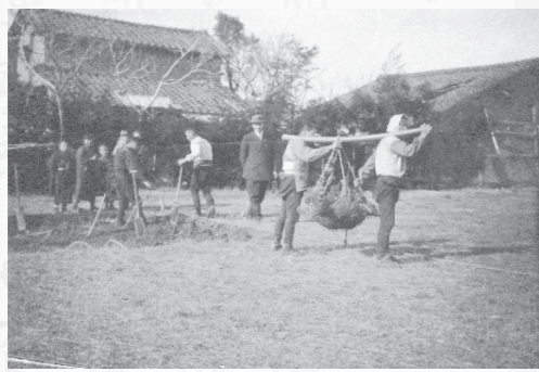
大正元年(1912年)秋頃撮影、建築現場の掘削土砂搬出スーツ姿は監督する渡米前の吉田悦蔵
